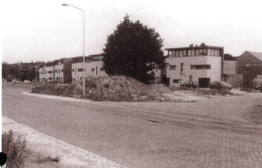
Aan de Sloterbeekstraat naderen de nieuwbouwwoningen hun voltooiing
